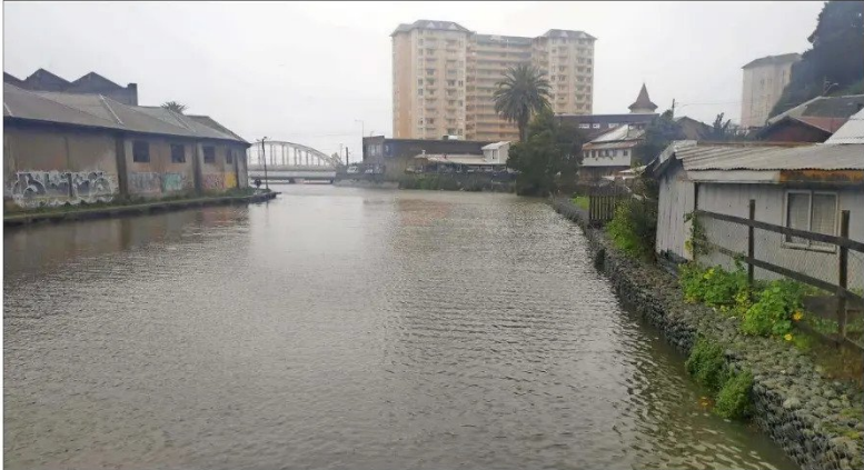
El desborde del estero Bellavista causó el anegamiento de nueve viviendas en Tomé. El sistema frontal avanza desde el sur al norte y, según la Dirección Meteorológica de Chile, sus efectos podrían llegar hasta Atacama.
