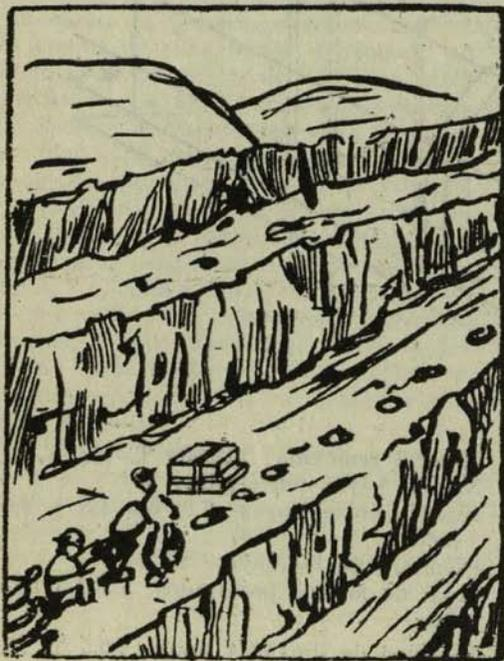
El explosivo que reúne todas las condiciones de seguridad es del tipo nitrato de amonio en estado granulado y habiendo colocado previamente la guía detonante se vierte a la perforación a través de un embudo de cobre. La guía forma línea continua dispuesta en serie desde el punto de mando hasta el fondo de cada perforación.
