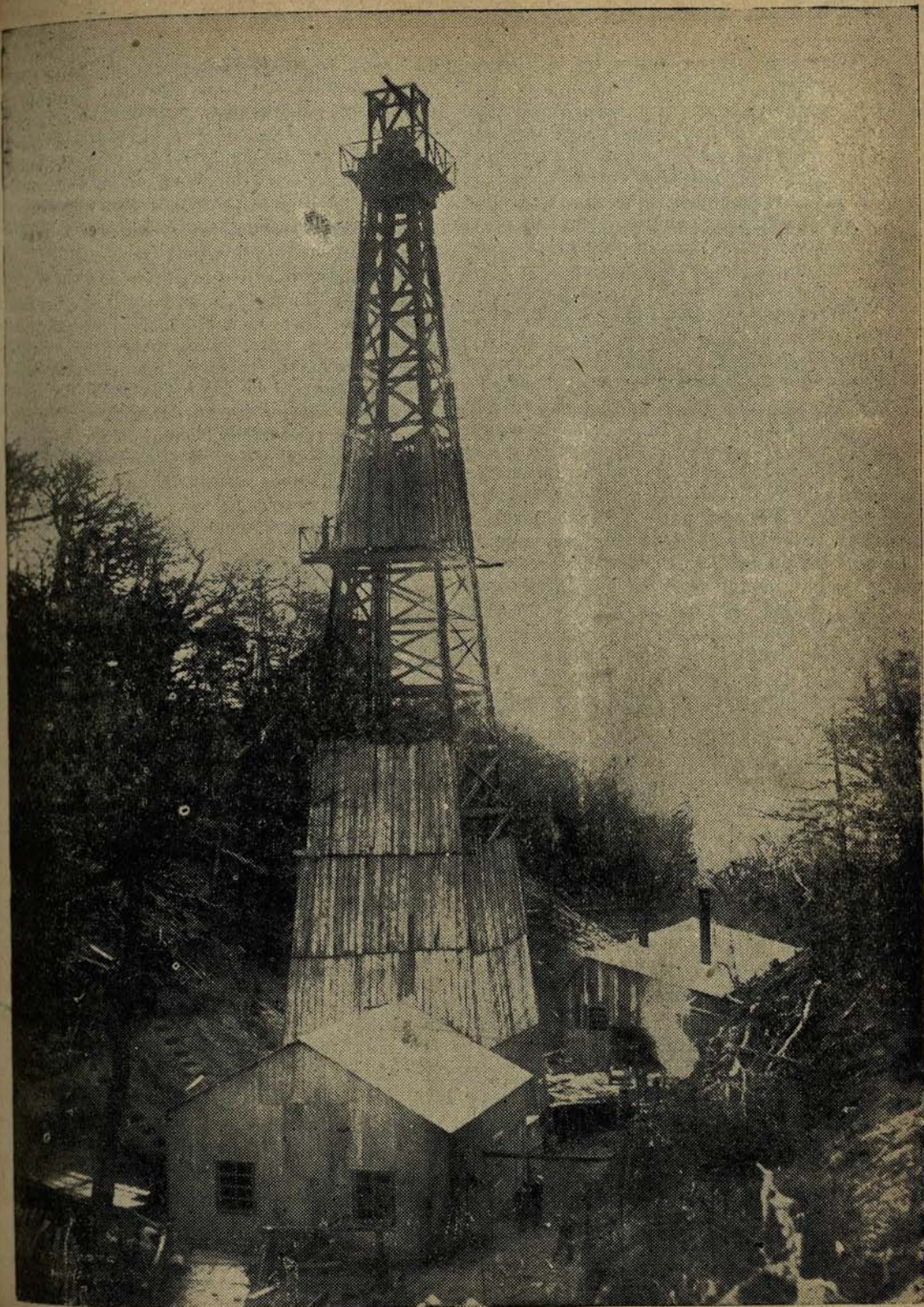
MAGALLANES.— Perforación R2, en Tres Puentes. — Equipo Rotativa Foraky.
