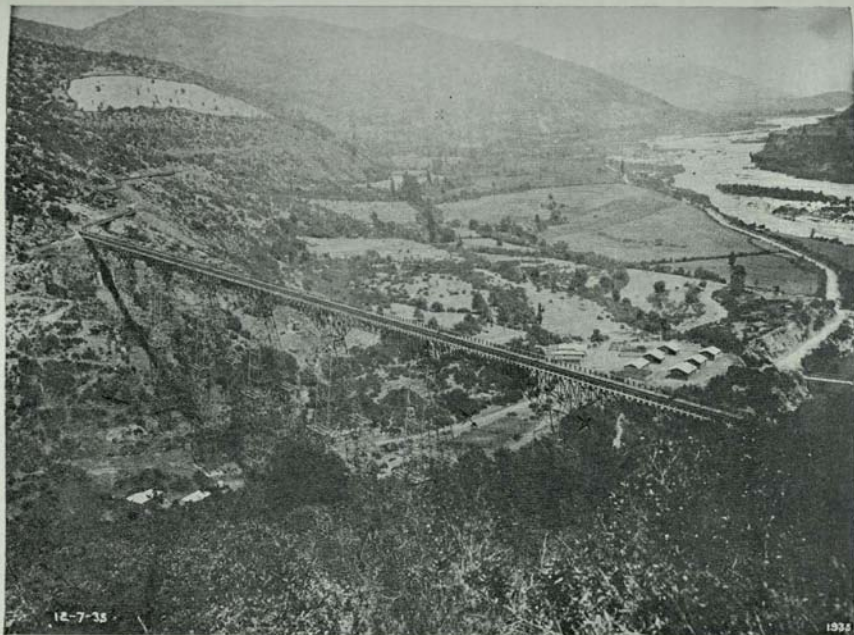
2.—Puente de Acero sobre el Río Claro que sostiene el canal de relaves
