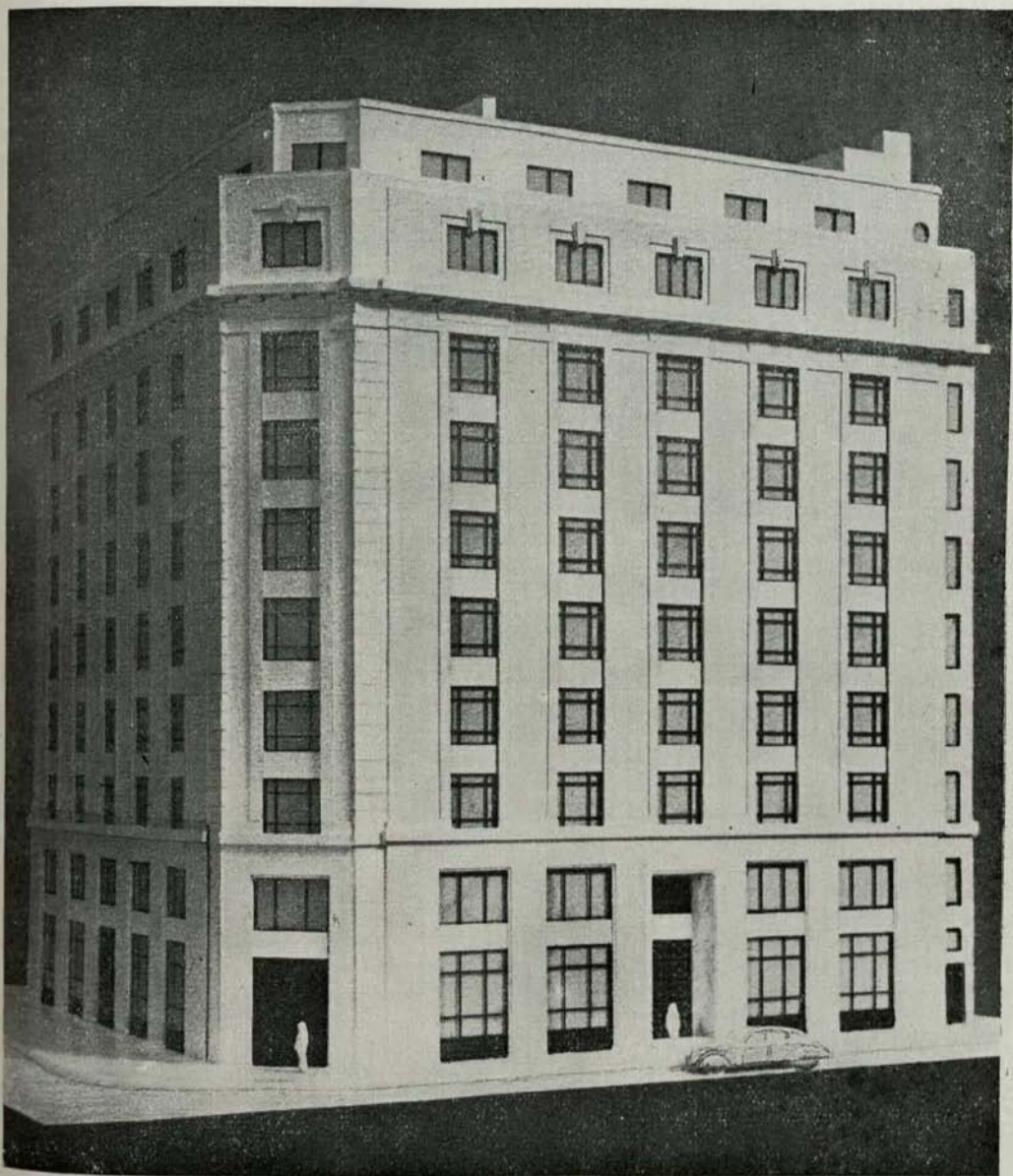
Edificio de la Corporación de Ventas de Salitre y Yodo. (en construcción).
