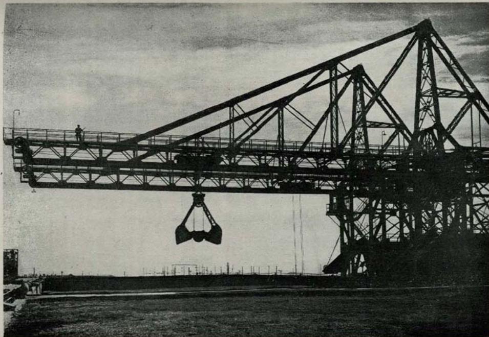
PUENTE DE DESCARGA DEL RIPIO.
