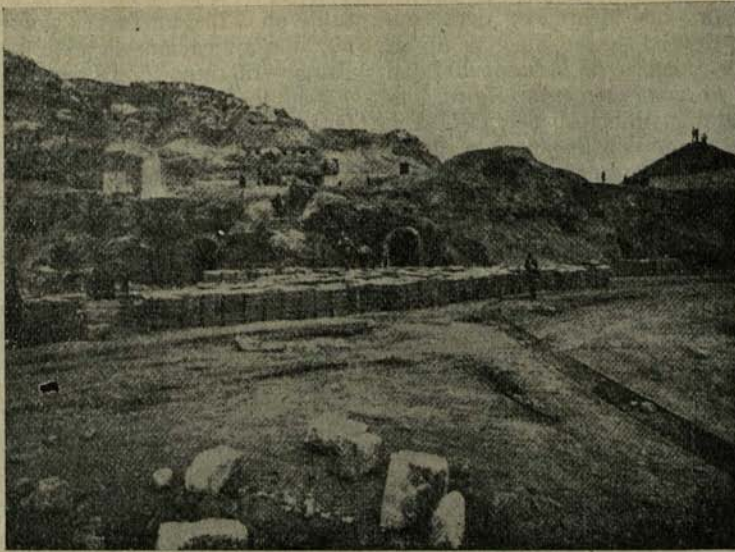
Fig. 7.—Hornos de cámara de la mina Trabia (Sicilia)
