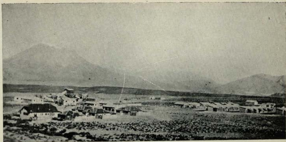
Caja de Crédito Minero.—Vista general de la Planta refinadora de azufre y sus campamentos.
