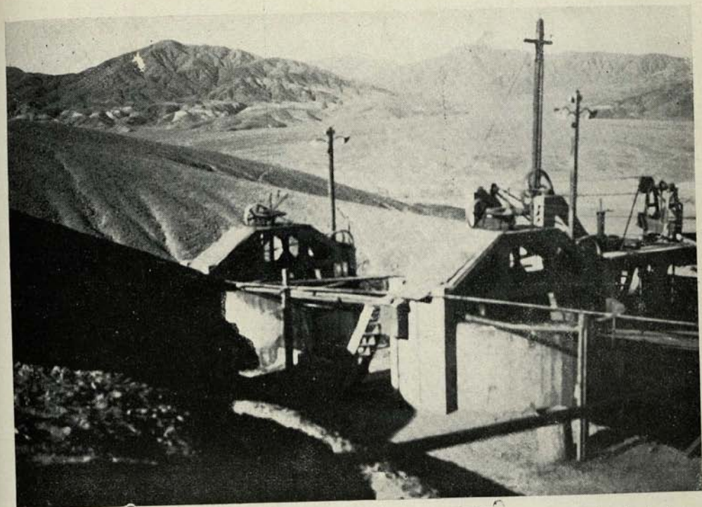
Caja de Crédito Minero.—Vista de los Agitadores de la Sección Cianuración de la planta de «El Salado».
