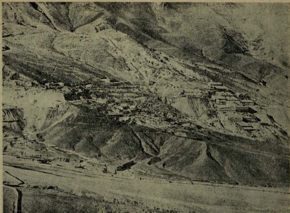
3.— Mineral de Pulacayo, vista del desmonte e ingenio.
