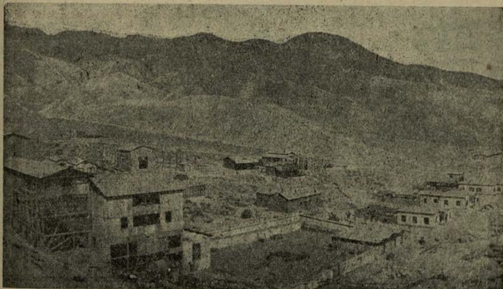
Caja de Crédito Minero.—Vista general de la Planta Beneficiadora de Minerales auríferos de Punta del Cobre (Copiapó).
