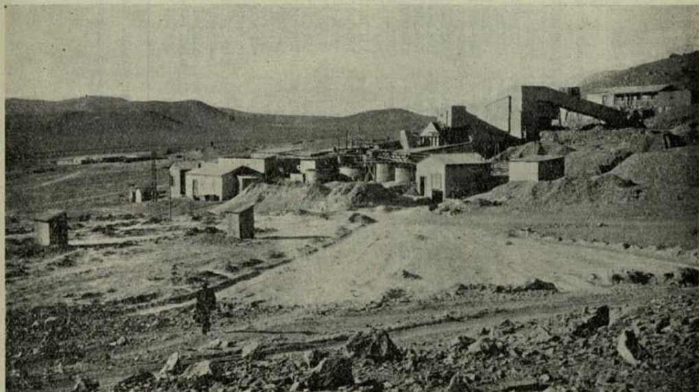
Compañía Minera del Guanaco.—Vista general de la planta de cianuración de minerales auríferos. (Taltal).
