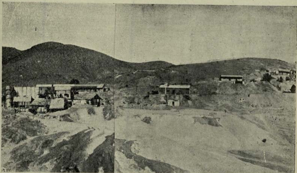
Sociedad Minera de Condoriaco.—Vista general de la planta de cianuración de minerales de oro y plata. (Coquimbo).
