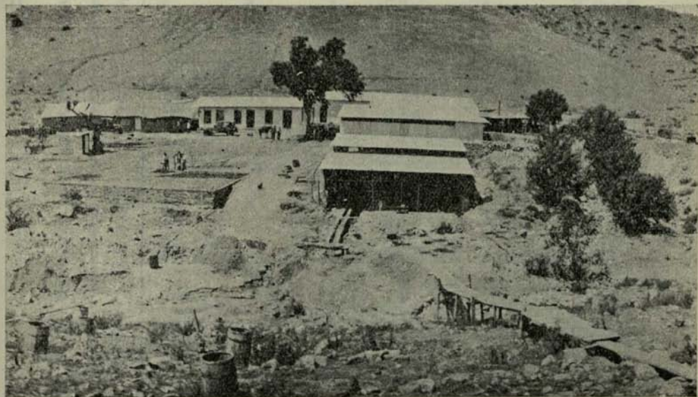
Compañía Minera de La Laja.—Planta de concentración por flotación. (Ovalle).
