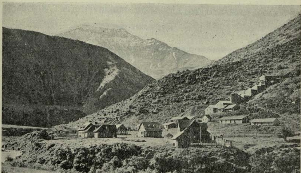
Compañía Minera Carlota.—Vista general de la planta y campamento. (Santiago).
