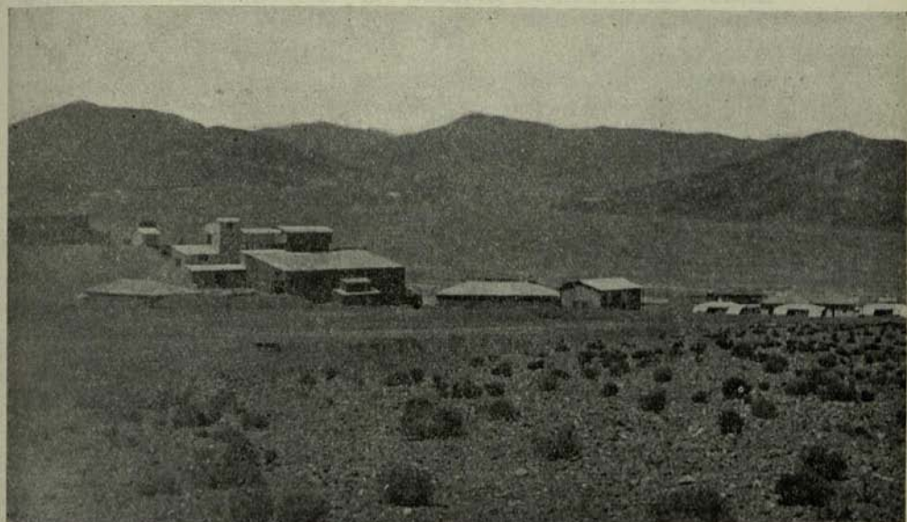
Caja de Crédito Minero.—Vista general de la planta de «El Salado».
