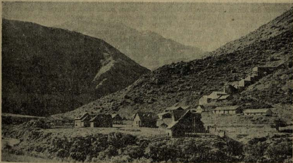
Compañía Minera Carlota.—Vista general de la Planta y Campamento
