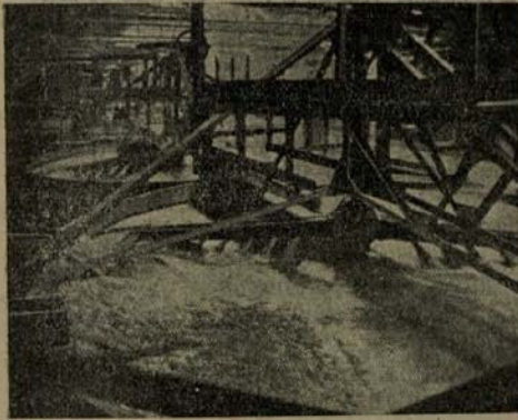
Fig. 4.—Agitadores Dorr en la Teck Hughes Mining Co.
