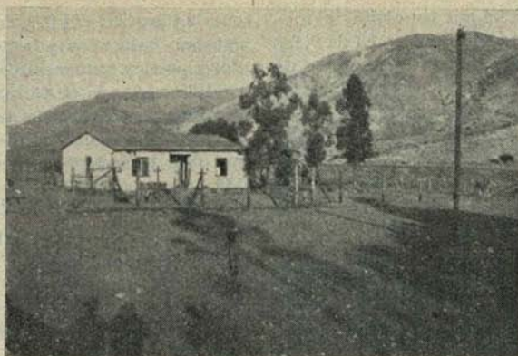
Escuela pública de la Planta Domeyko
