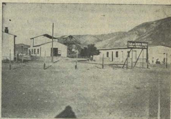
Vista general de la Planta Domeyko
