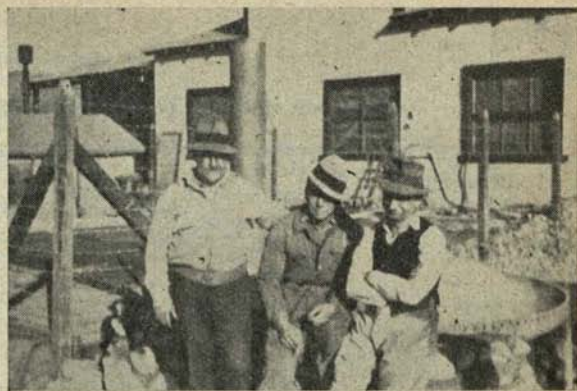
Personal técnico de la Caja que tuvo a su cargo la construcción de la Planta
