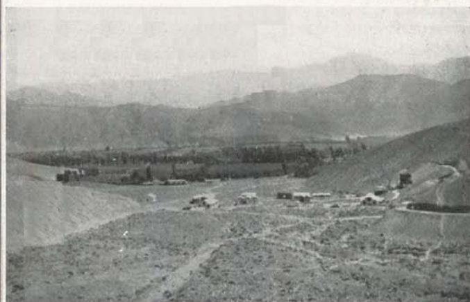
PROVINCIA DE ATACAMA.—Vista general de la Planta Regional de concentración construída por la Caja de Crédito Minero en Punta del Cobre (Copiapó).
