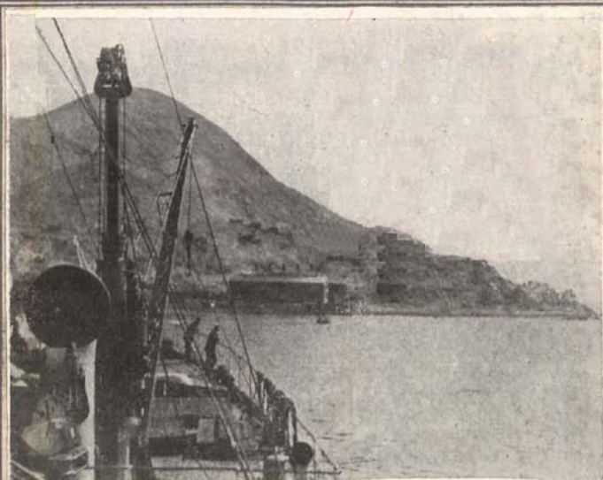
Departamento de Chañaral.—Planta Termo-Eléctrica de la Andes Copper Mining Co. (Barquito).
