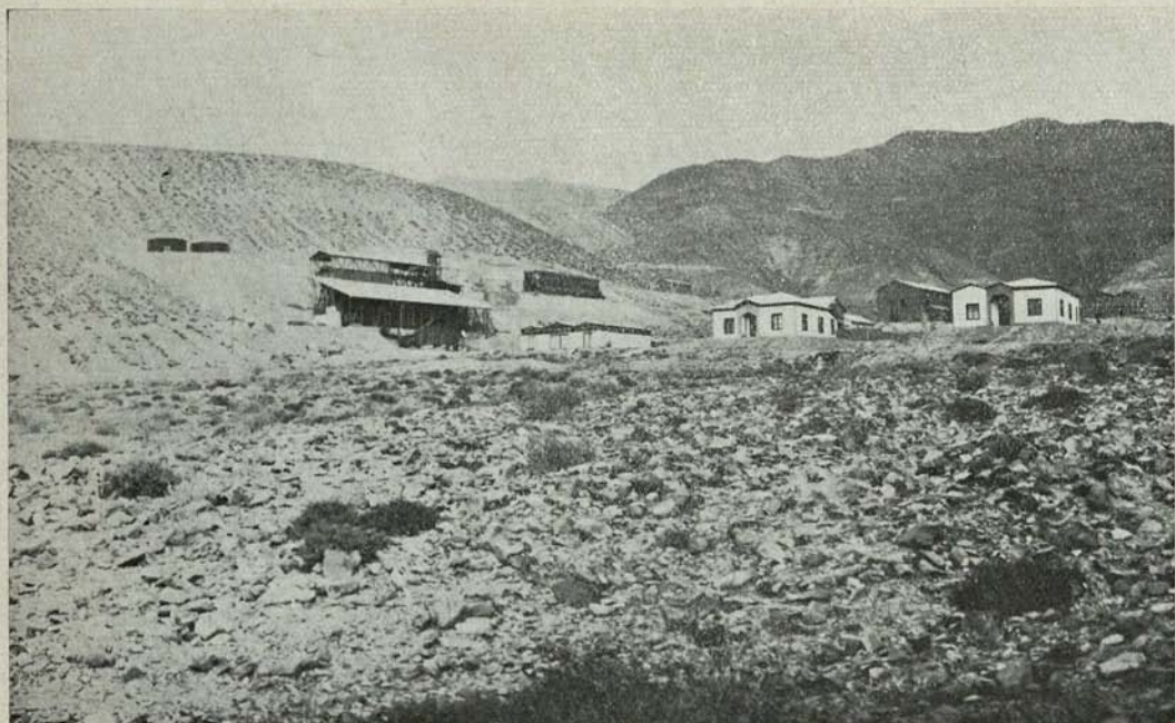
Planta regional de concentración construída en Punta del Cobre, cerca de Copiapó. Casa de fuerza, laboratorio y bodega.
