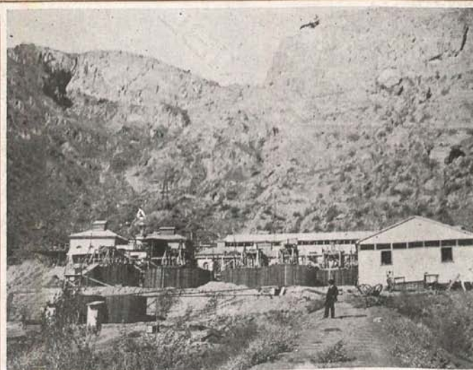
PROVINCIA DE ATACAMA.—Planta de cianuración de minerales de plata que la Compañía Minera "Elisa de Bordes" construyó con un préstamo de la Caja de Crédito Minero.
