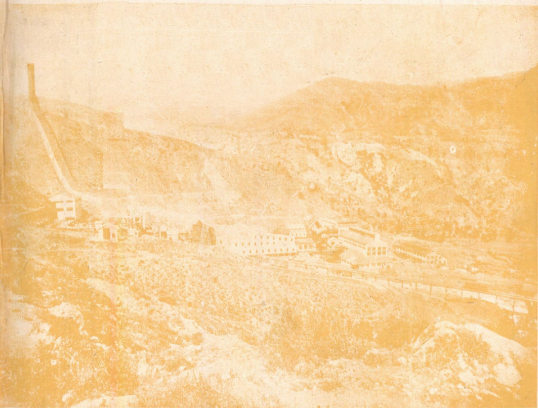
El Teniente.—Nueva planta de Fundición de Caletones.
