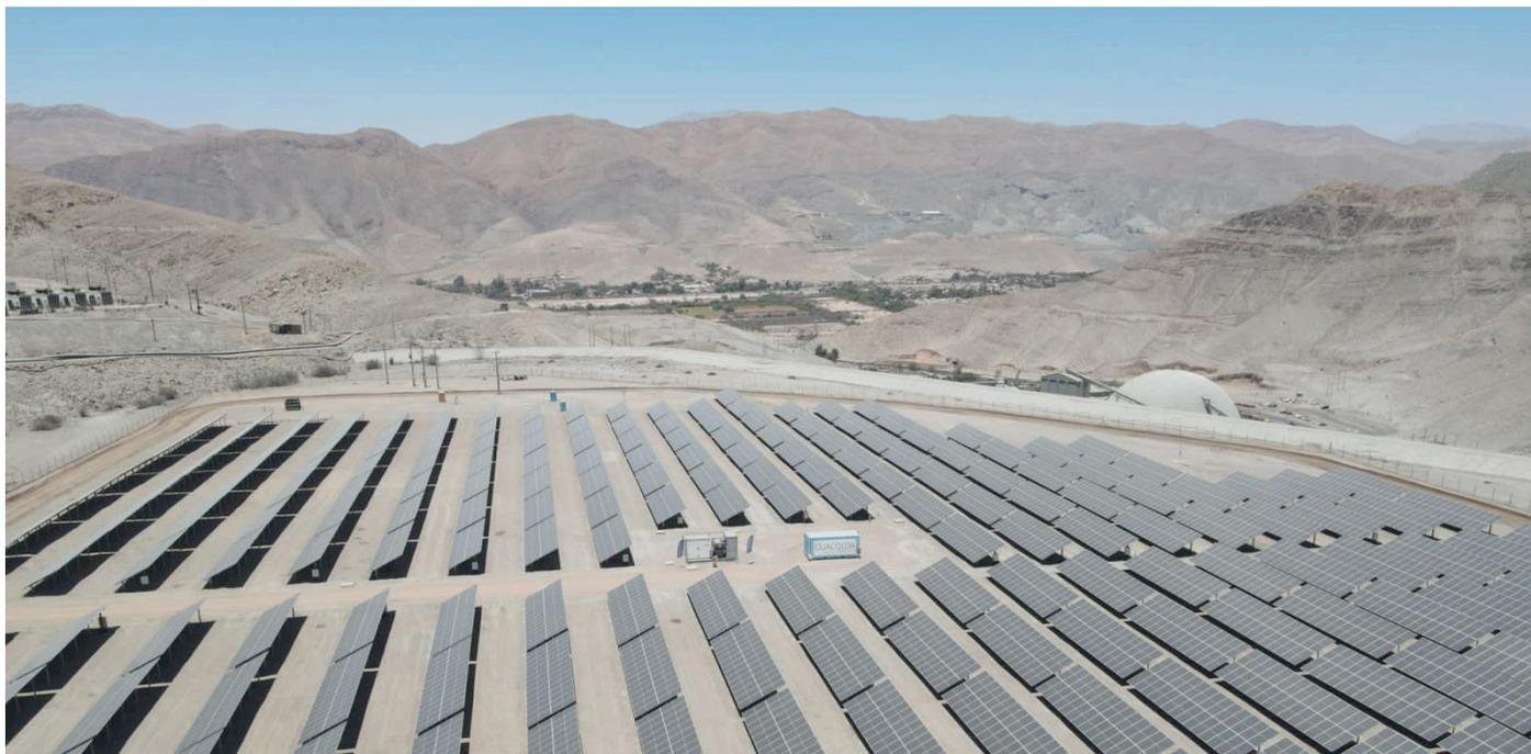
*El parque solar, que se encuentra emplazado en un terreno de 4,5 ha en Tierra Amarilla, contó con una inversión de US\$ 3 millones y tiene una capacidad de 3 MW, energía que será usada para la planta de flotación San José de Pucobre.*
