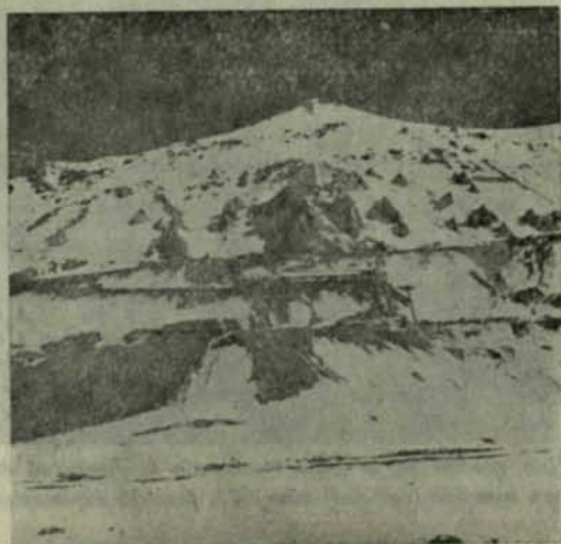
Aspecto general de los accesos a la superficie de la mina.
