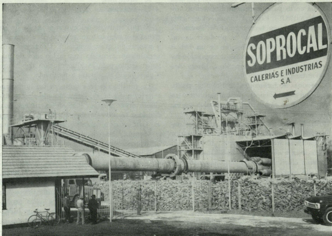
Horno y planta de beneficio de SOPROCAL en Melipilla
