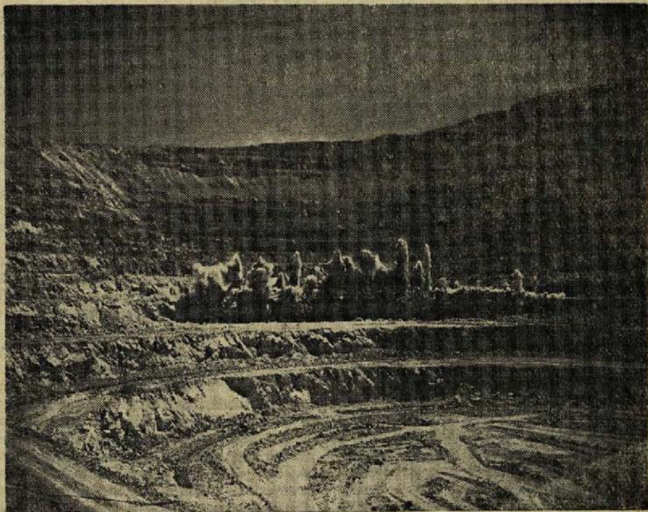
Una explosión en la Mina. Los tiros más corrientes están destinados a volar 100.000 toneladas de piedra minerales.
