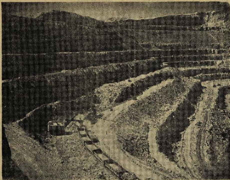
Vista parcial de la Mina, con la pala mecánica en trabajo.
