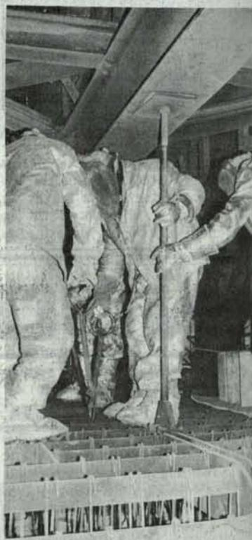
Reposición de refractarios en horno de fundición.
