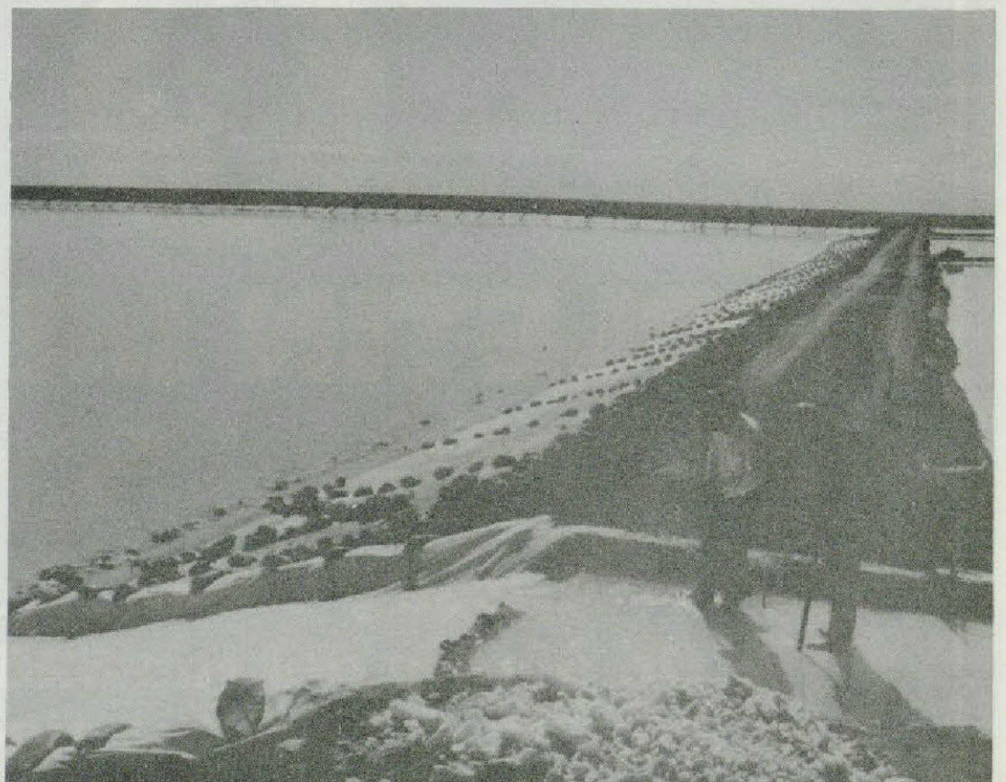
Faenas en cancha de lavado de sales de litio.
