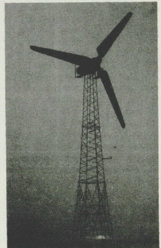
Desde una velocidad de 2 a 4 mts. por segundo, el viento activa los molinos.
