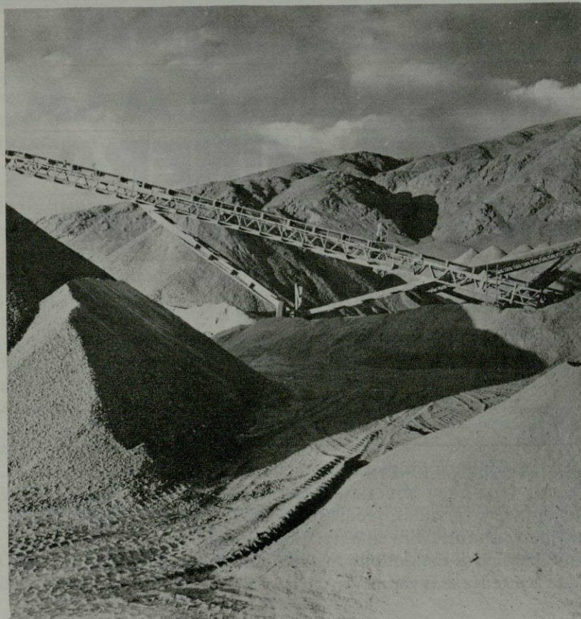
Estas mismas correas transportadoras podrían servir para el acarreo hacia las pilas.
