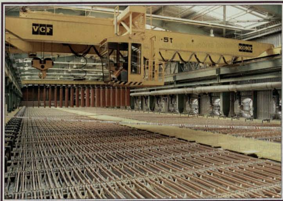
El mineral es sometido a un proceso de lixiviación bacteriana en que se utiliza el sistema BTL de Pudahuel, seguido por extracción por solventes y electrorrecuperación, que permite a la empresa obtener cobre en forma de cátodos.
