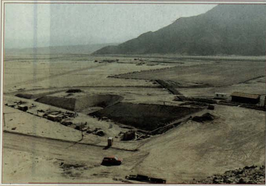
Estas son las instalaciones de la Planta Biocobre, de la Sociedad Punta del Cobre S.A., cuando se encontraban en plena construcción.
