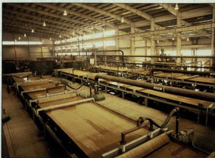
Sala de Filtros de La Coipa, a 140 kilómetros de Copiapó y a 4.000 metros de altura.
