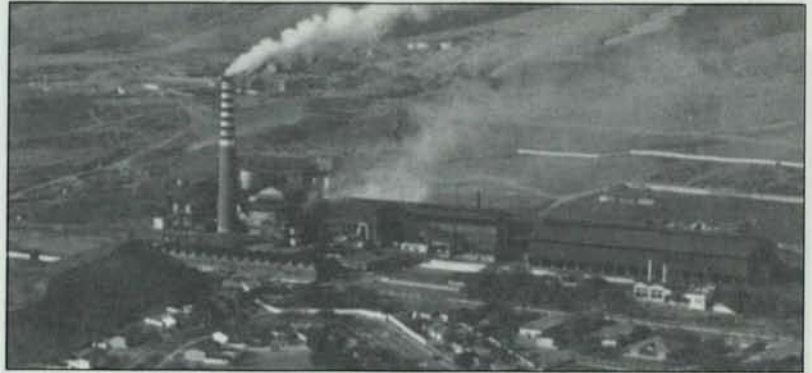
Vista general de las instalaciones de la fundición, que inició sus operaciones el 27 de diciembre de 1951.
