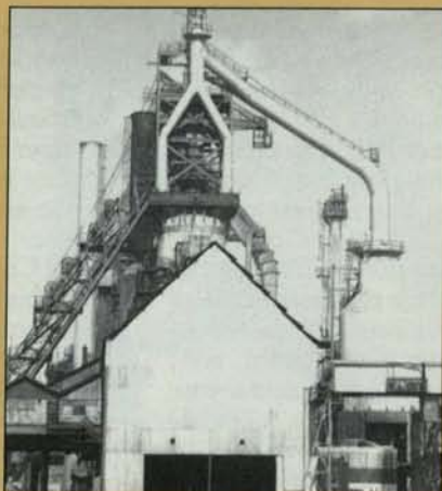
Siderúrgica de Huachipato.
