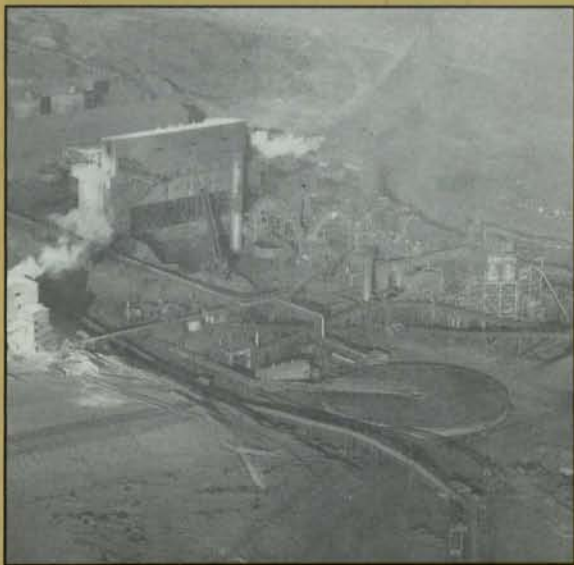
El laberinto de correas transportadoras rodea la planta de pellets de la CMP.
