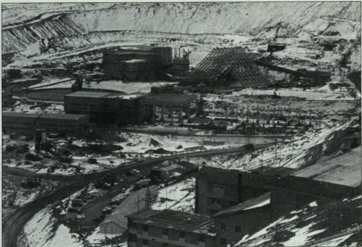
Instalaciones mina Disputada de Las Condes
