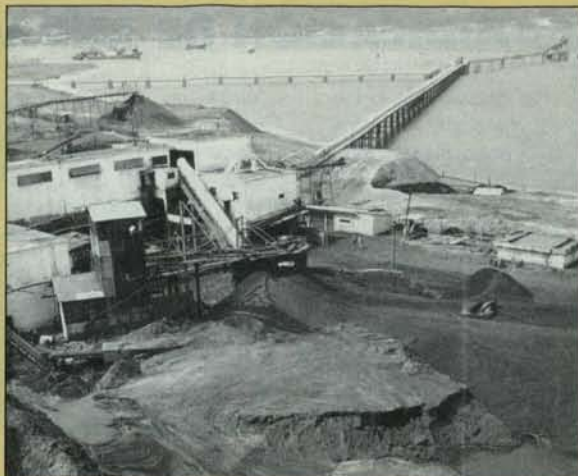
Instalaciones de Enacar.
