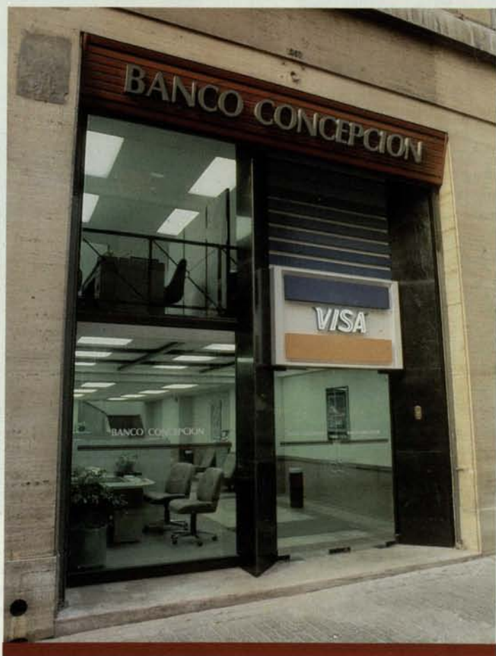
Fachada de la oficina de atención de clientes VISA, del Banco Concepción.
