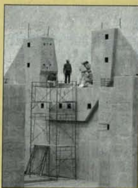
Ampliación concentradora en Chuquicamata.
