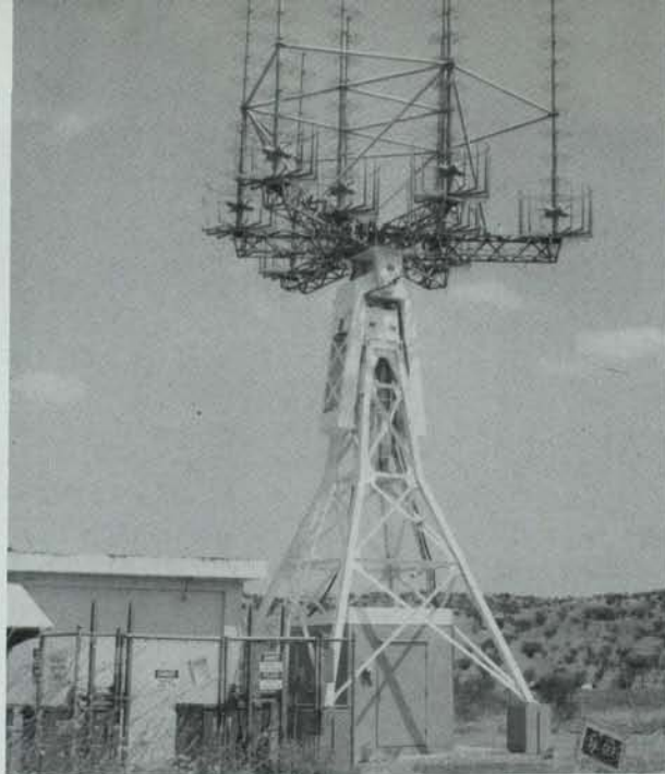
Una de las antenas de Telecomando del Centro.
