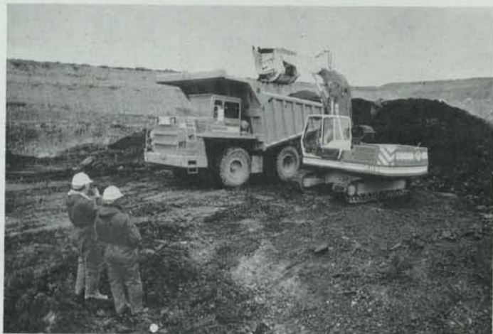
Labores de cargamento del carbón.
