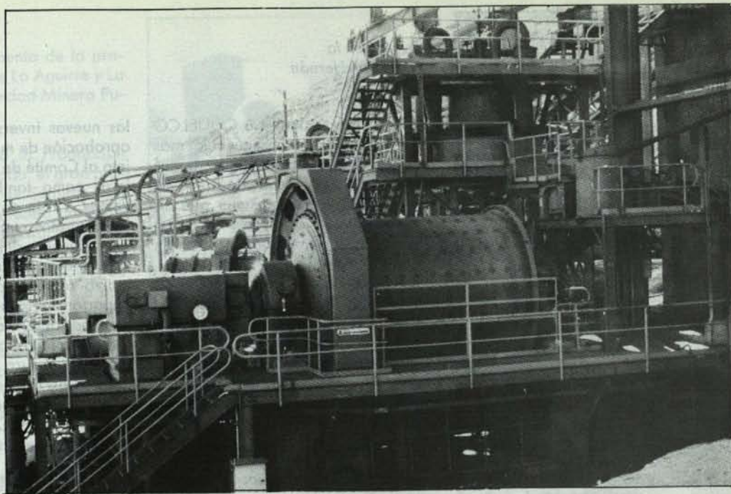
Instalaciones de molienda en Minera Ojos del Salado, Copiapó.
