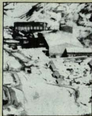
Planta de tratamiento. El Indio.
