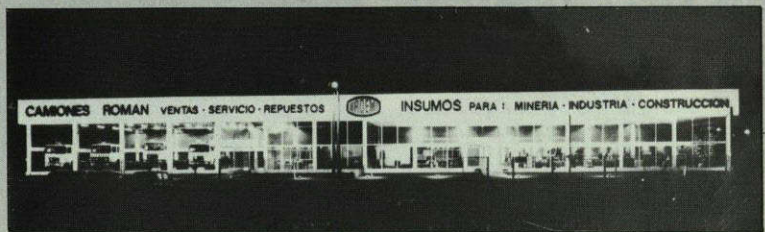
Frontis del nuevo edificio.
