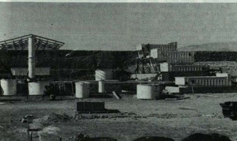
Planta de yodo en construcción. (I Región).
