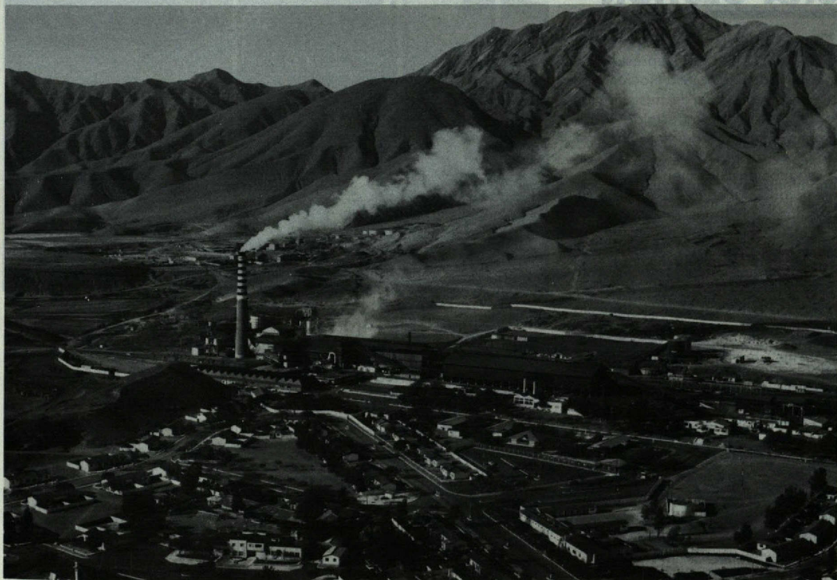
Refinería de Paipote.
