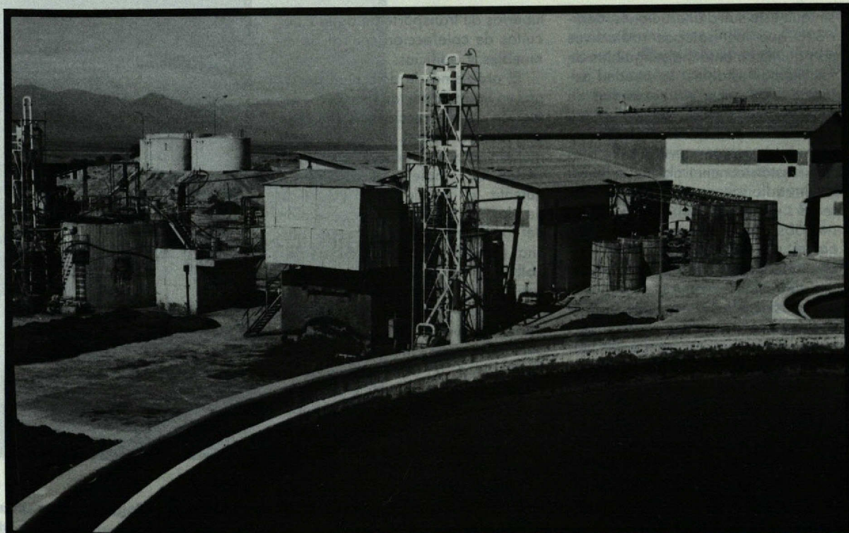
Estanques de lixiviación.
