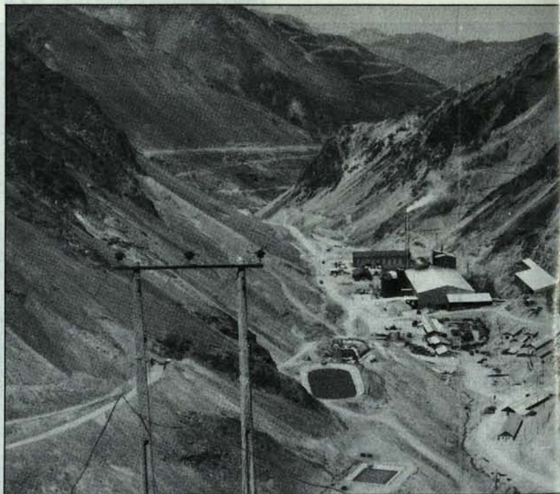
Campamento de la compañía minera El Indio, uno de los últimos proyectos en el sector minero.
