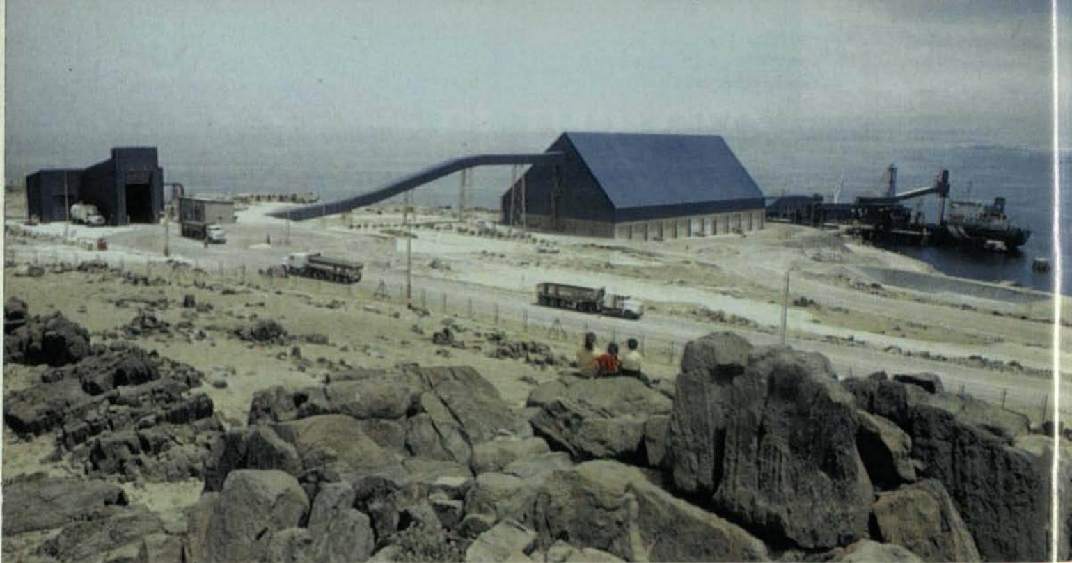
*A partir de 1995, entró en operación el Puerto Limpio Mecanizado de Punta Padrones, construido por Minera Candelaria para el embarque del concentrado de cobre.*
