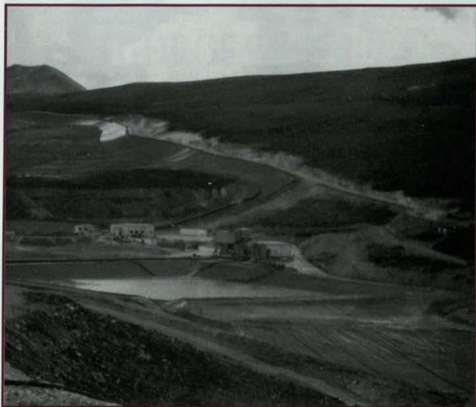
Instalaciones de la mina Yanacocha, en Cajamarca. Pad Impermeabilizado con geomembrana y tubería protegida contra derrames, en canal permeabilizado.
