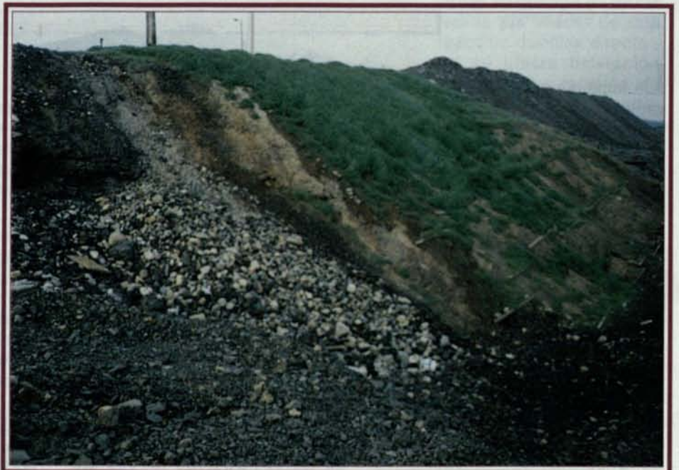
Año 1989, control de aplicación de hidrosiembra a los dos meses.
