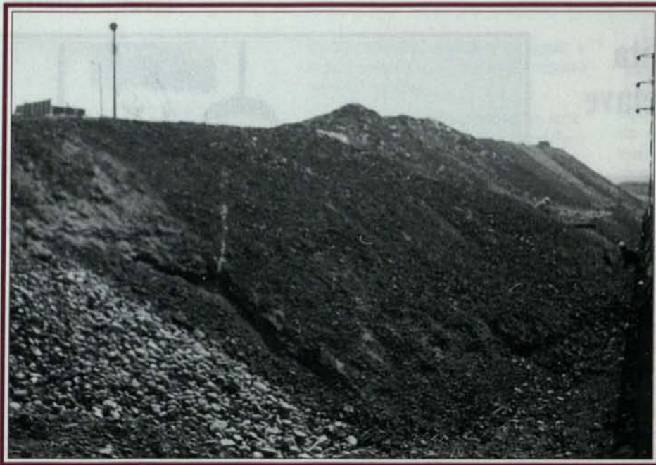
Fundición Chagres: Talud de escoria de fundición antes de aplicar la hidrosiembra.
