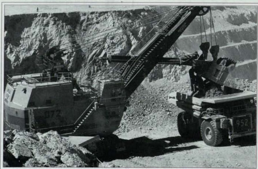
A 53 kilómetros al sureste de Chañaral y 900 metros sobre el nivel del mar, se encuentra el proyecto Manto Verde de la Empresa Minera Mantos Blancos y que actualmente se encuentra en construcción.
