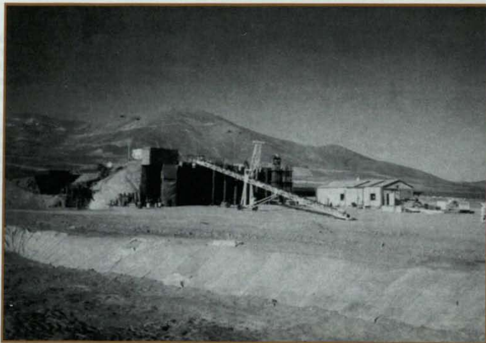
Esta es la Planta Piloto de Zaldívar en sus comienzos. La definitiva tiene una capacidad de tratamiento de 120 mil toneladas anuales de cátodos de cobre de alta calidad.
