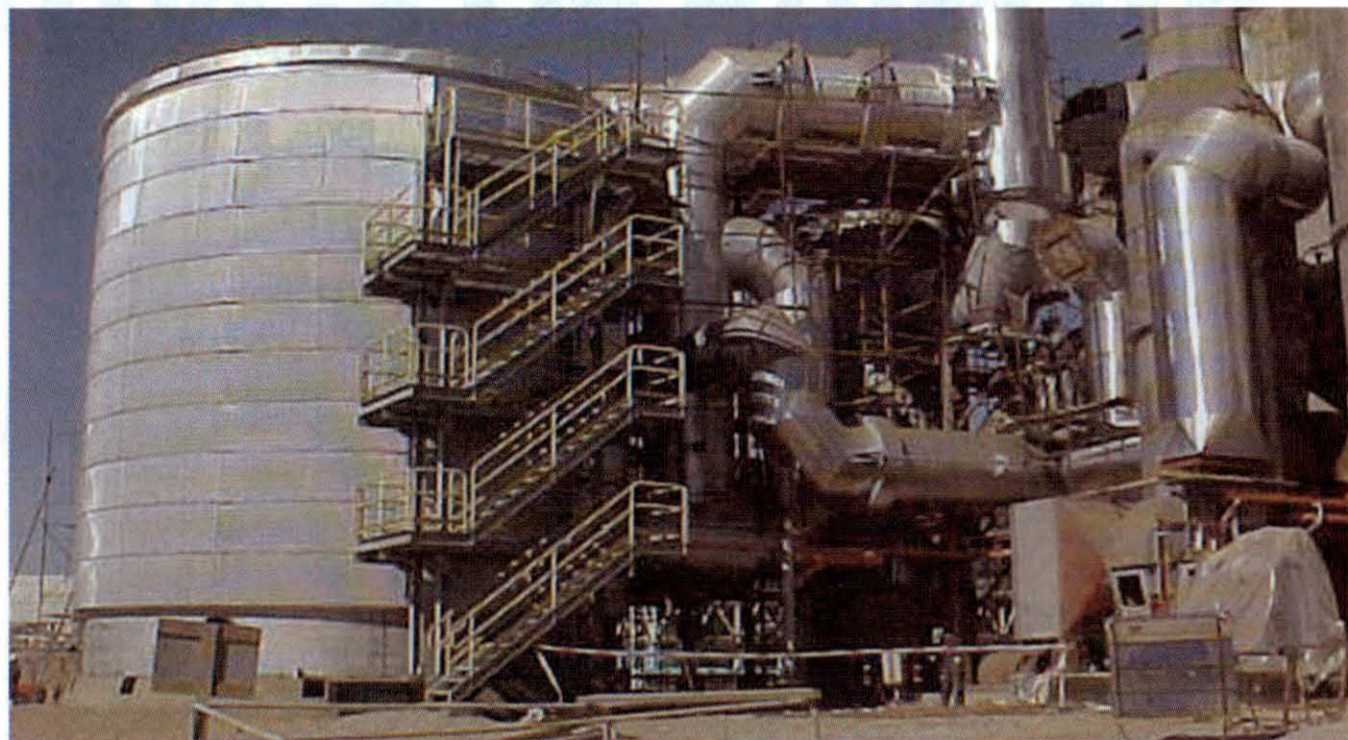
Los trabajos de mejoramiento de la Planta de Acido N° 2 finalizaron recientemente en los plazos programados y sin accidentes con tiempo perdido.
