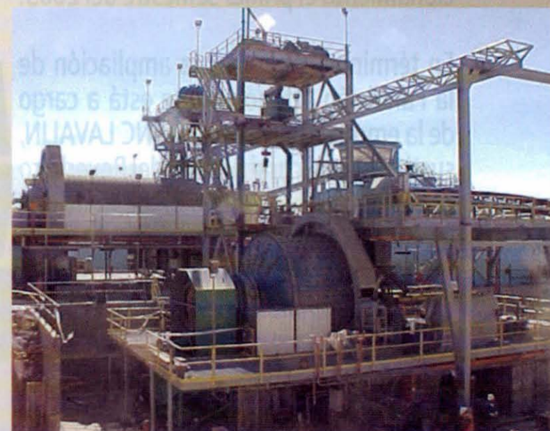
Vista general de la planta Tratamiento de Escoria.
