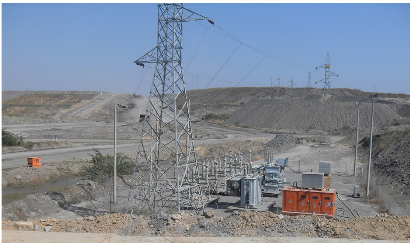
Gentileza de DV Ingeniería.
