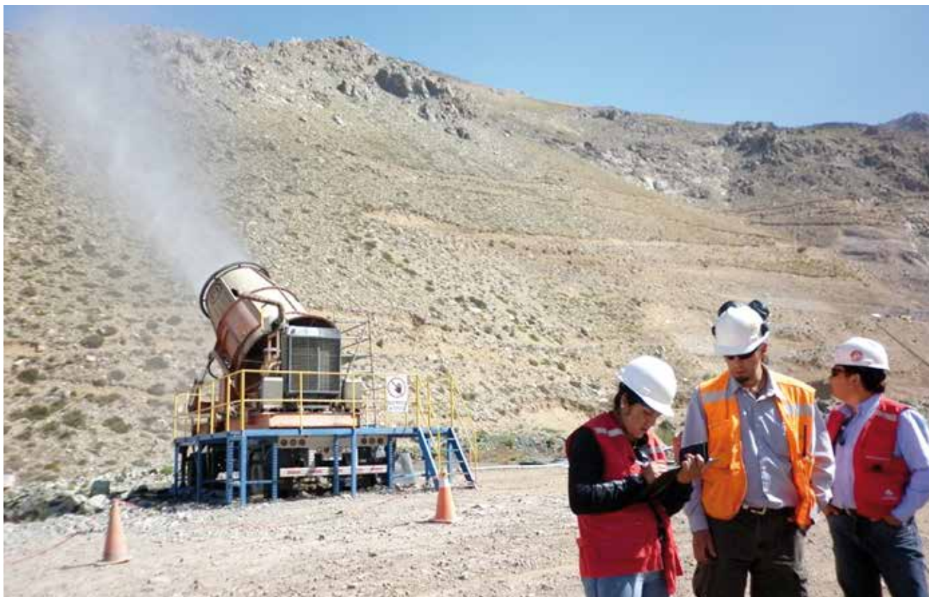
La humectación de caminos es una de las opciones que utiliza la minería para el control de material particulado.
