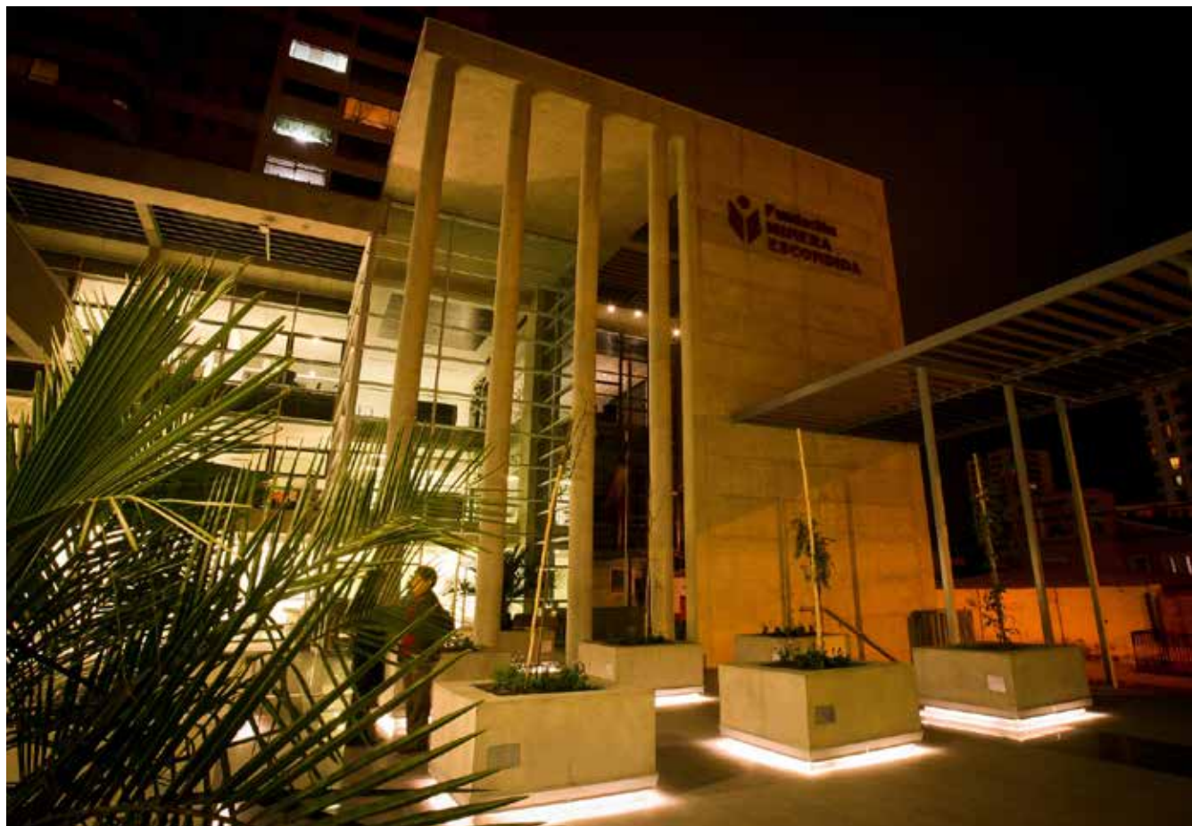
Edificio Comunitario y Espacio Cultural Fundación Minera Escondida
