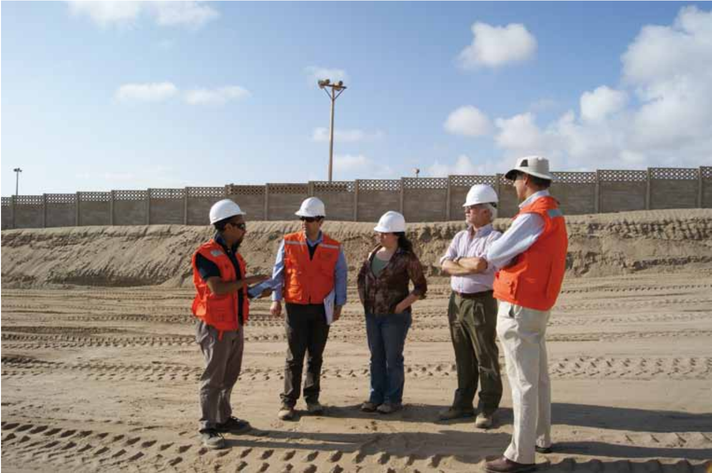
A tres meses de la feria, se encuentran a full las obras en los nuevos terrenos.
