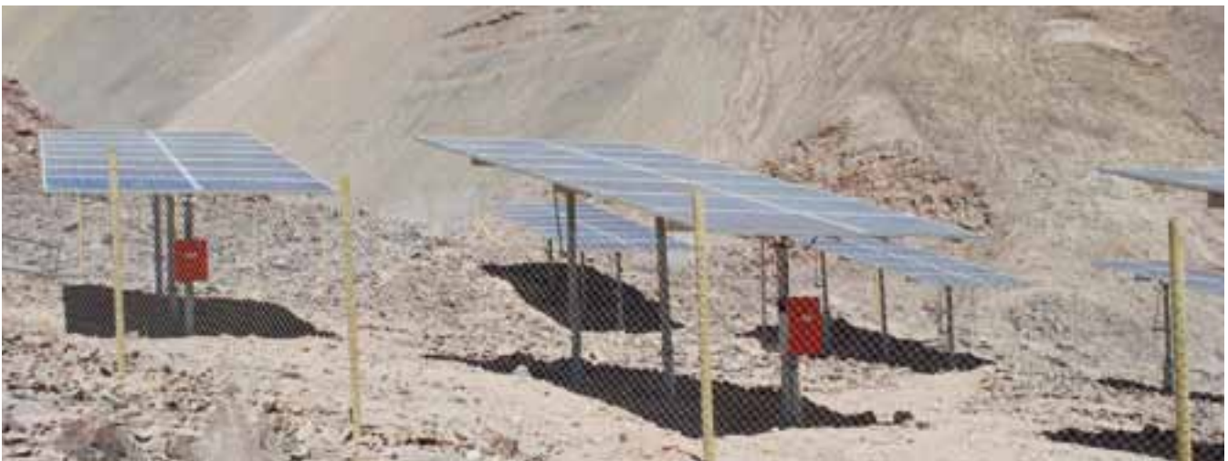
El proyecto de energización sustentable se desarrolló en etapas. En la primera, se instalaron paneles solares fotovoltaicos, una turbina eólica y un banco de baterías para almacenar la energía excedente.
