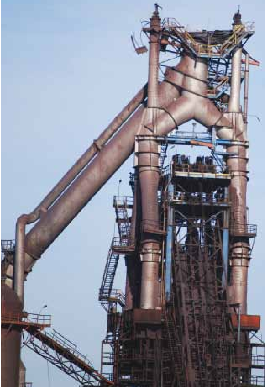
El violento movimiento telúrico provocó daños en la sección de producción primaria: muelle, altos hornos, planta de coque y acería.
